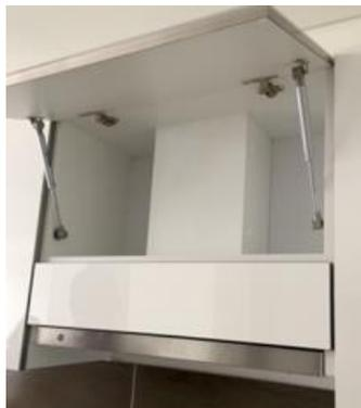
Cuando la campana se instala de forma recirculante, requiriendo la rejilla de evacuación, el mueble NO puede instalarse a tope con el cielo raso o placa.
